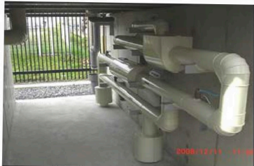
貯水タンクの入水管へ設置
